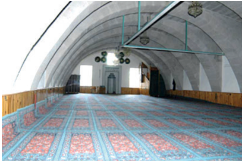
Resim 4. Üst Örtüyü Taşıyan Harim İçi Kemerlerin Görünüşü (Güneşli Mescidi, Özbek ve Arslan, 2008: 174)
