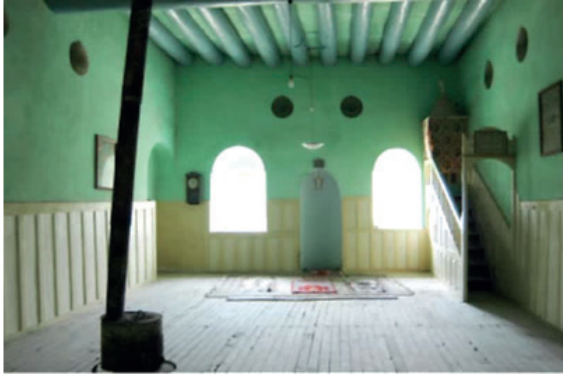
Resim 6. Üst Örtüyü Taşıyan Harim Duvarları İle Tomrukların Görünüşü (Tavlasun Aşağı Mahalle Mescidi Özbek ve Arslan 2008: 251)
