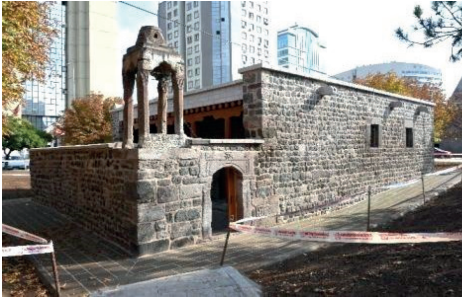
Resim 11. Cephe Duvarında Çörtentlerin Görünüşü (Kalaycıoğlu Mescidi)
