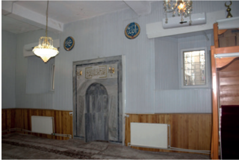
Resim 18. Helvacıdede Mescidi Kirişli Betonarme Tavan Görünüşü
