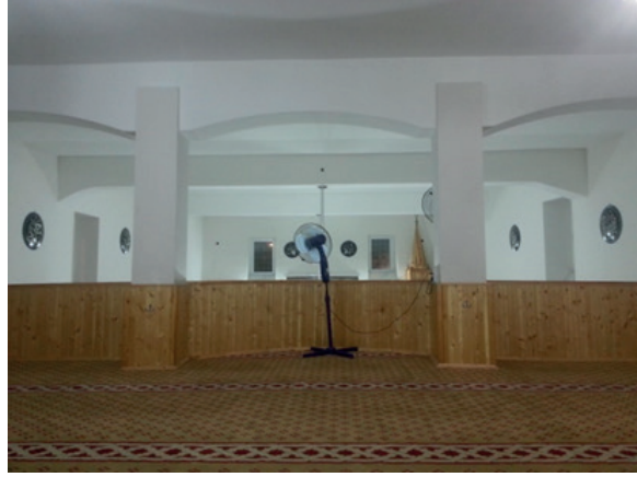
Resim 21. Haciveled Mescidi Betonarme Tavan Döşeme Ve Kirişlerinin Görünüşü
